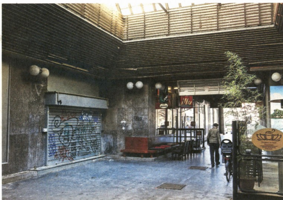
Največji problem je lamelni strop, ki golobom omogoča gnezdenje.
