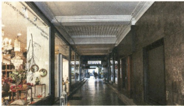
Prenovljeni strop v delu pasaže ob Cankarjevi cesti, kar je vsaj v tem delu prehoda rešilo težavo z golobi.
